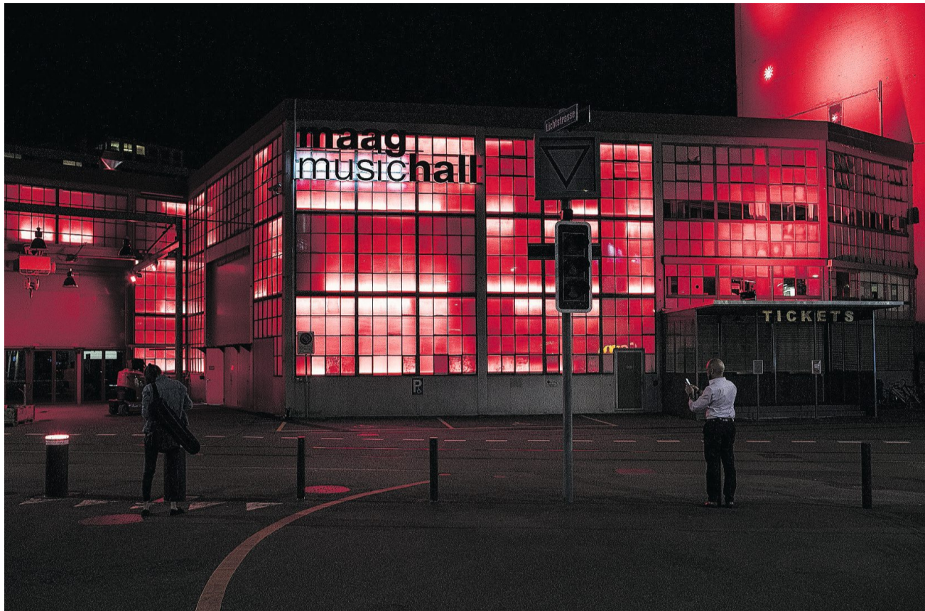
Die Maag-Halle ist ein wichtiges Element des Zürcher Kulturlebens. Sie soll einem Wohnhochhaus weichen.
